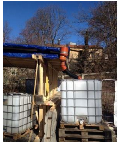
Lösning för uppsamling av regnvatten för användning till damm bekämpning
