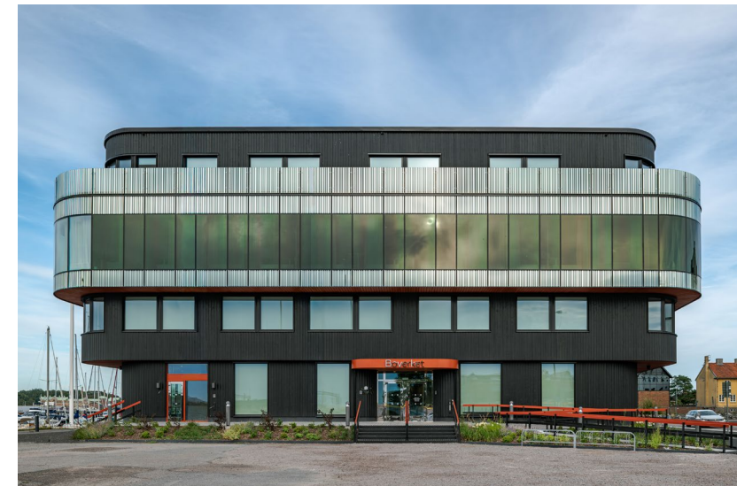
Boverkets huvudkontor Skeppsbron 5 i Karlskrona, certifierat enligt BREEAM och preliminärt enligt NollCO2. Fastighetsägare är Vacse. Foto: Antonius van Arkel
